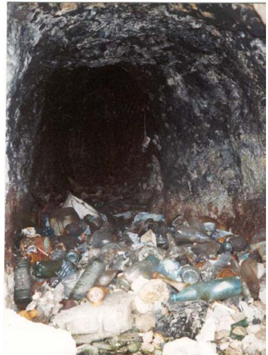
Photo 43 : intérieur de l'égout (Photo : I. Poitou)
